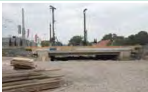
Baustelle Unterführung Heroldstraße in Münster-Mecklenbeck Bild: Udo Puteanus
