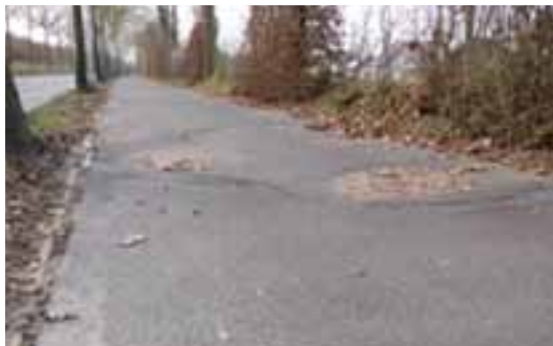
Schlimmer geht's nimmer: Kopfsteinpflaster und Wurzelauflagebrüche auf dem Zweirichtungsradweg an der Roxeler Straße - Bild: Udo Puteanus
