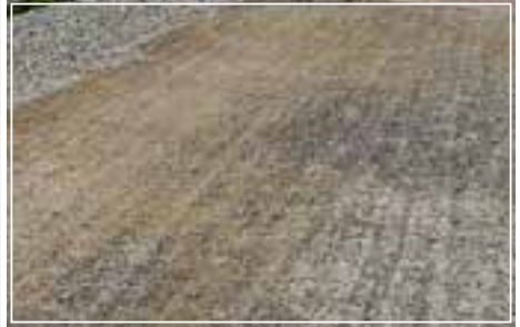
Split/Gravel: Deckschicht ohne Bindemittel
