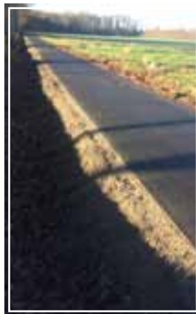
Neue Schwarzdecke mit ungesicherter abfallender Kante (Stadt Münster) und Aufpflasterungen (Kreis Warendorf) Es fehlen die Randmarkierungen.
