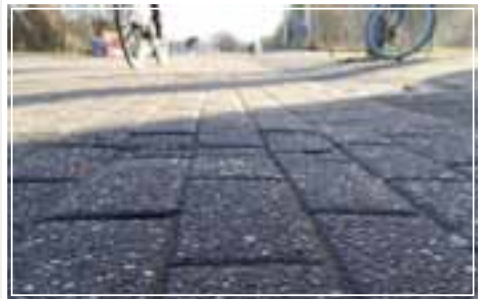
Deckschicht aus gefastem Betonverbundstein
