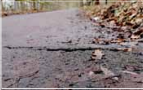
Schwacher Oberbau: Baumwurzel-Aufbruch
