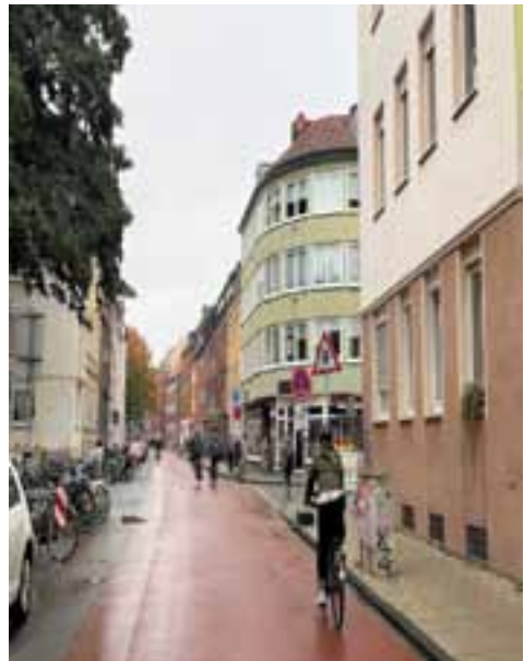
Die zur Fahrradstraße Plus umgebaute Schillerstraße ©Stadt Münster
