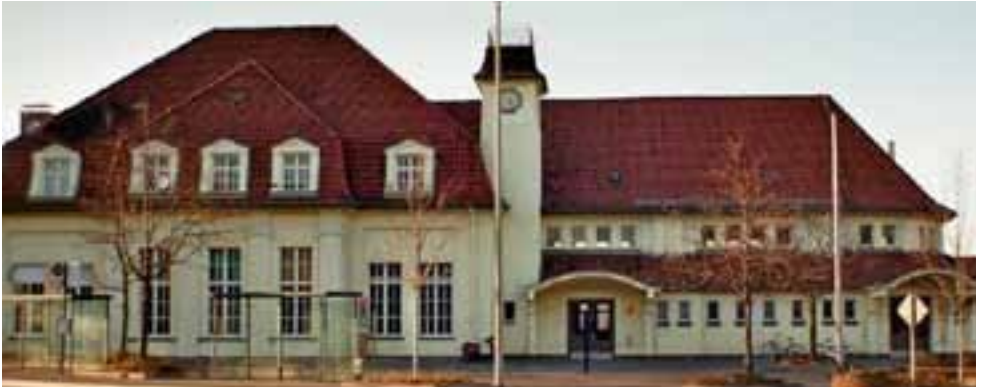
Der Bahnhof Neubeckum, Standort einer Radstation? ©Martin Kamps
